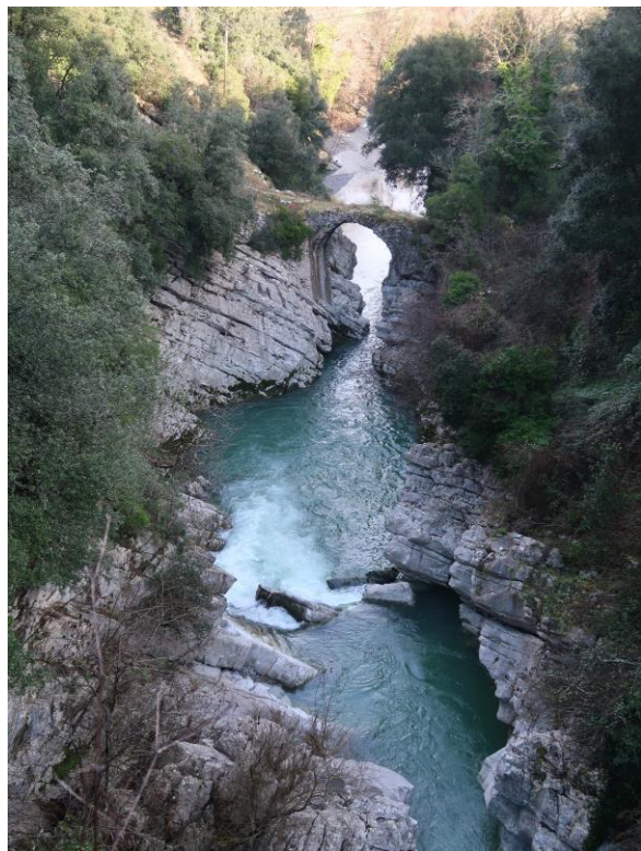
Ponte medioevale a valle di Felitto
